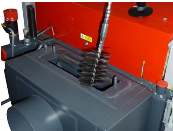
Пример очистки дымовых путь с проволочной щеткой - верхняя крышка
